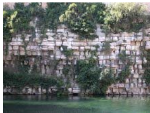
Muro de carga de la presa, aguas abajo
