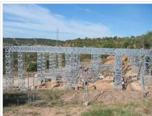
Estructura para cubrir las Termas I. | E.F.
